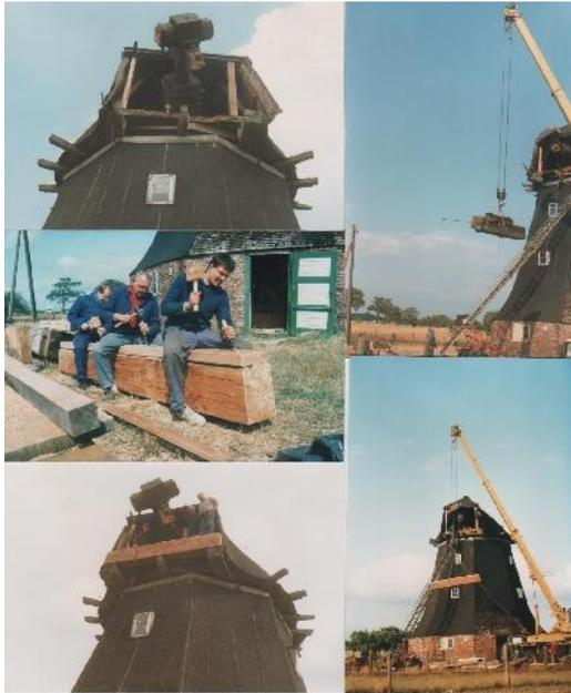
Neben großflächig fehlendem Dachbelag (Holzschindeln), teilweise lockeren Schalbrettern und dem dadurch hervorgerufenen Durchregnen sorgte ein im Bereich des Auflagers völlig zerstörter Wetterbalken dafür, dass das tonnenschwere Flügelkreuz mitsamt Wellkopf und Welle nicht gerade sicher gelagert war. Ähnliches galt für die völlig verfaulten Fughölzer am hinteren Ende der Kappe, auf denen die Stiele des Windrosenbockes stehen.
