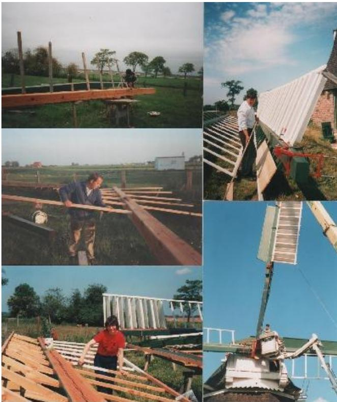
Von April bis August 1997 wurde das Flügelkreuz (bzw. Rutenkreuz) in Eigenleistung neu angefertigt. Es handelt sich um Jalousieflügel. Aus Sicherheitsgründen wurde nur ein Rutenpaar mit Jalousieklappen bestückt. Die Spannweite beträgt 21,60 m, ein Jalousieflügel wiegt ca. 750 kg. Seit dem 31. August 1997 ist die Mühle zumindest äußerlich wieder komplett.
