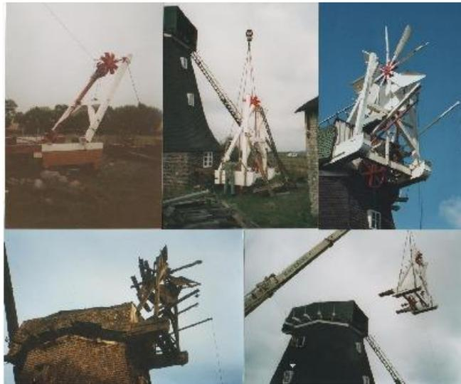
Da von der alten Windrose nur noch die Eisenteile wiederverwendbar waren, wurde die ganze Konstruktion nach dem Muster des Originals neu aufgebaut. Der Zusammenbau erfolgte am Erdboden, am 28.09.1996 wurde die gesamte, ca. zwei Tonnen schwere Holzkonstruktion mit einem 25-Tonnen-Autodrehkran montiert. Die abgeschnittenen Enden der Fugbalken wurden durch eiserne Kästen (in der Form der ehemaligen Balkenköpfe) wieder verlängert.
